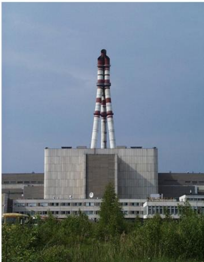
Her ses bygninger, der indeholder Reaktor 1 samt de ansattes kantine og bar. Reaktoren er baseret på russisk højteknologi.
